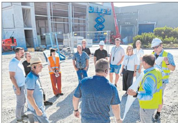
Bauleiter Marcus Leicht (rechts) und Ensinger-Geschäftsführer Frank Lehmann (Zweiter von rechts) informieren die Gäste über den Stand der Bauarbeiten. Foto: p
