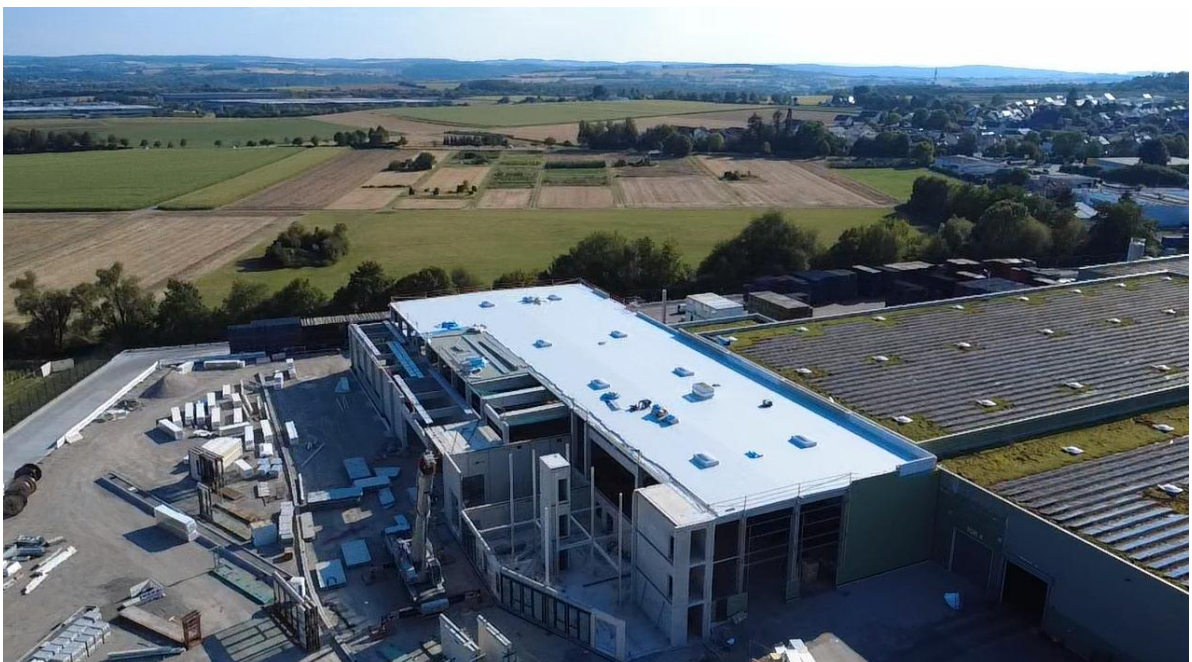
Aktueller Baufortschritt der neuen Verladehalle mit Büroräumlichkeiten im Betriebsteil Ensingen Ost.
